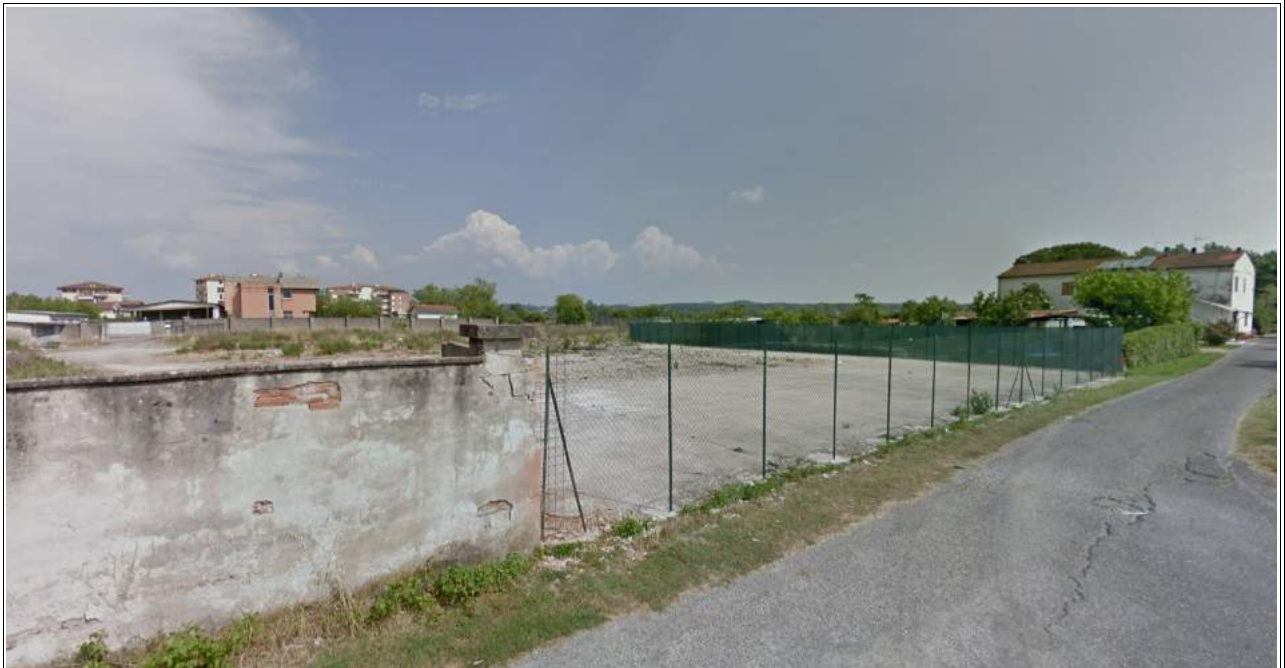
Fotografia n. 3 - Veduta lato Nord/Ovest
