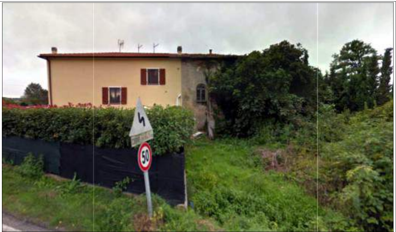
Fotografia n. 2 - Veduta lato Nord
