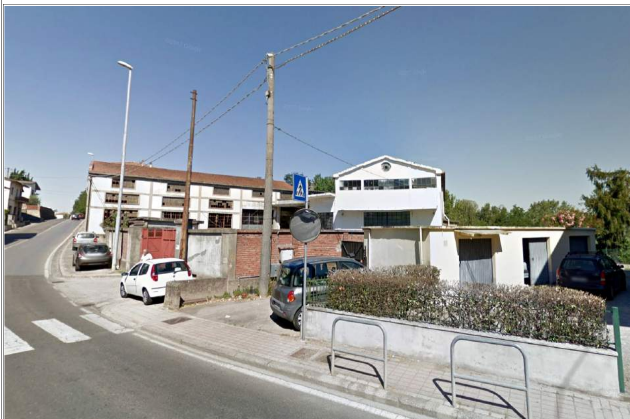
Fotografia n. 1 - Veduta lato Sud/Est
