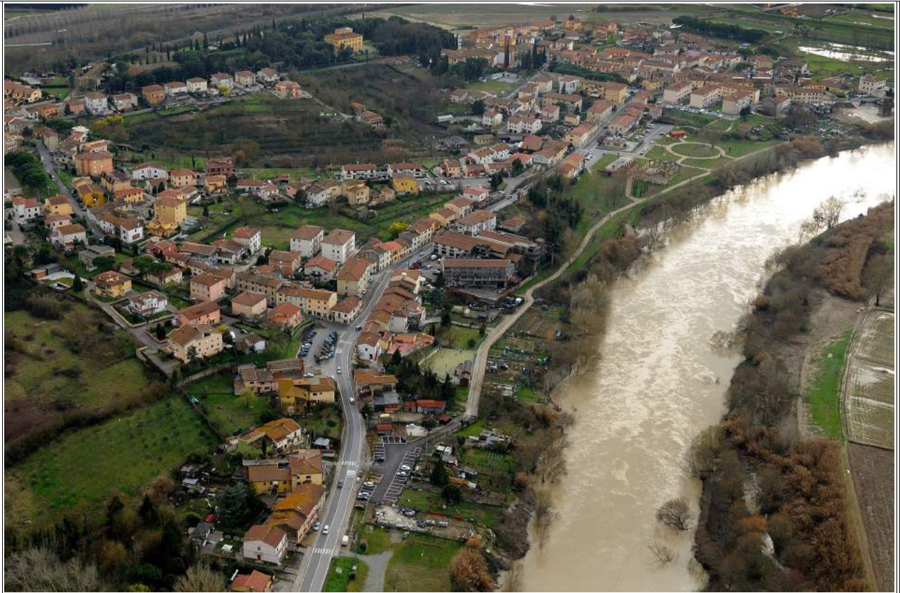
Fotografia n. 2 - Veduta lato Fiume Arno
