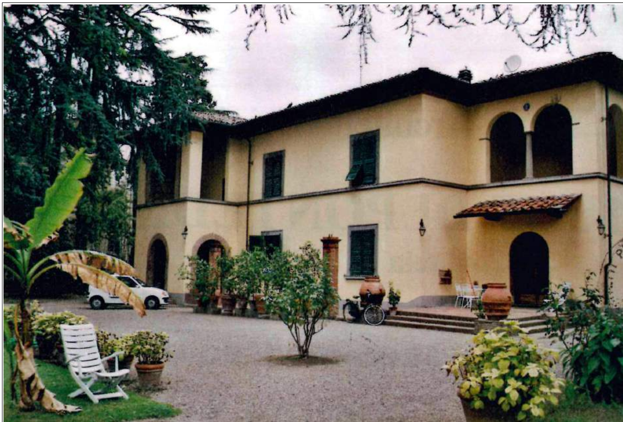
Fotografia n. 1 - Veduta lato Sud/Est
