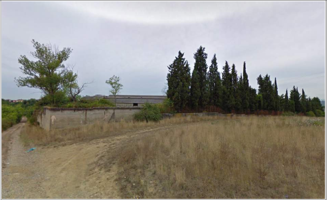
Fotografia n. 2 - Veduta lato Sud/Est
