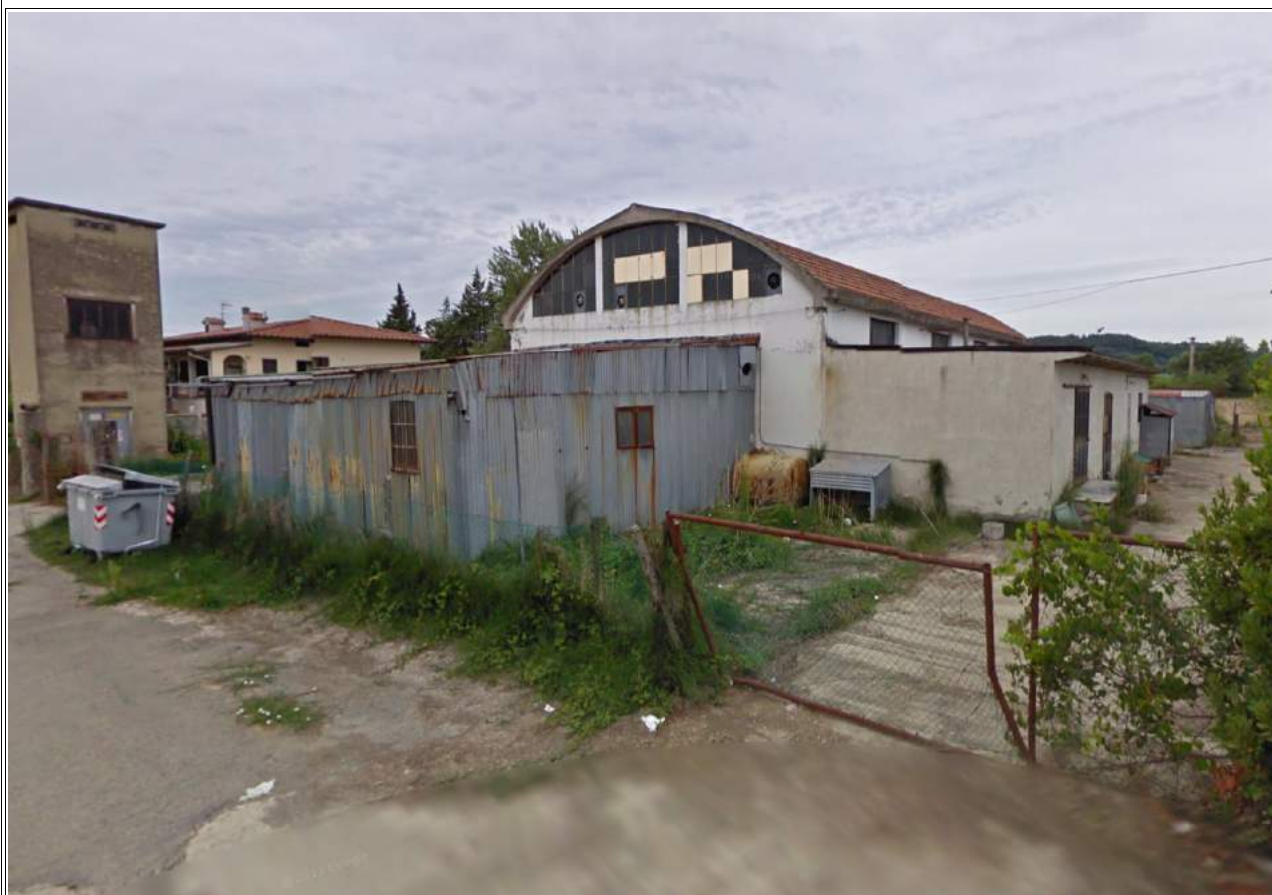
Fotografia n. 1 - Veduta lato Sud/Est
