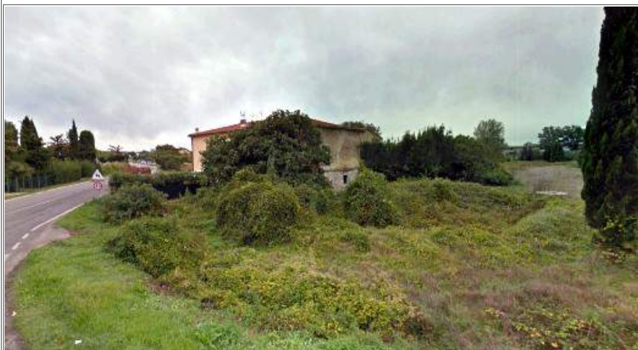
Fotografia n. 1 - Veduta lato Nord/Ovest
