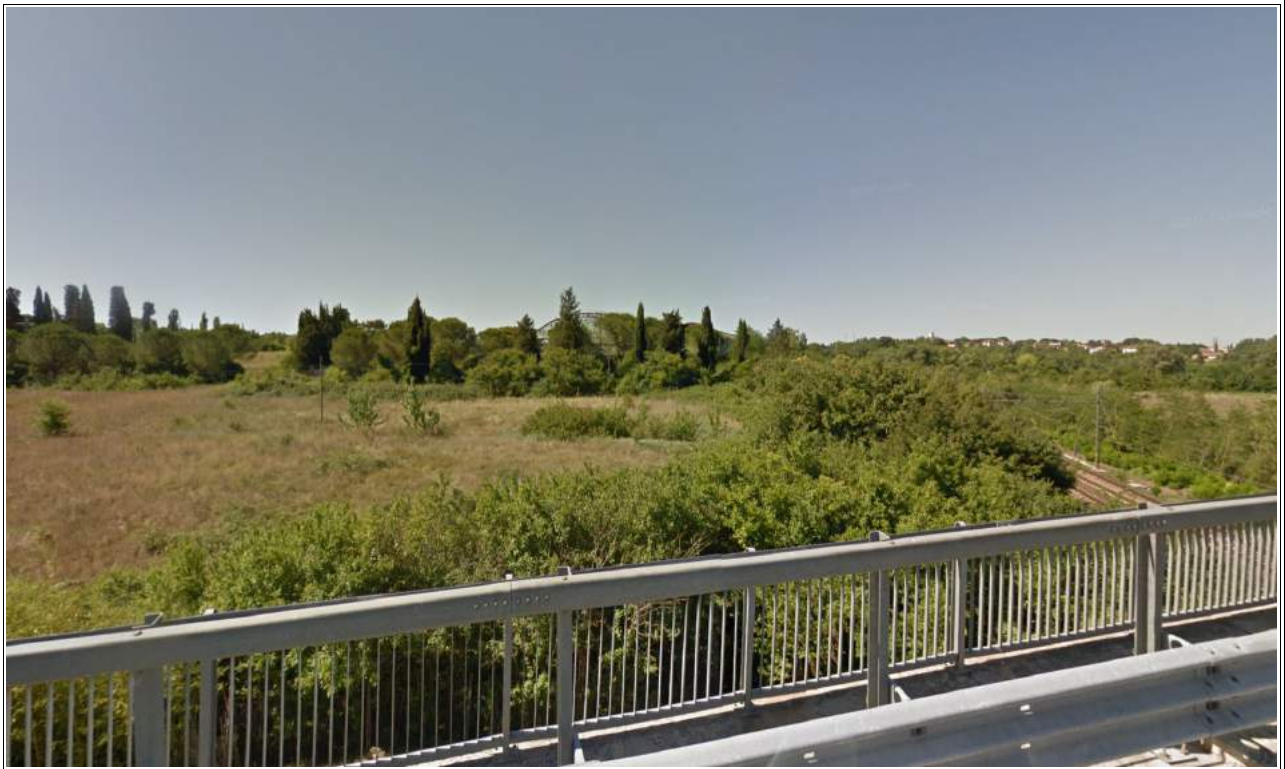
Fotografia n. 3 - Veduta lato Sud/Est
