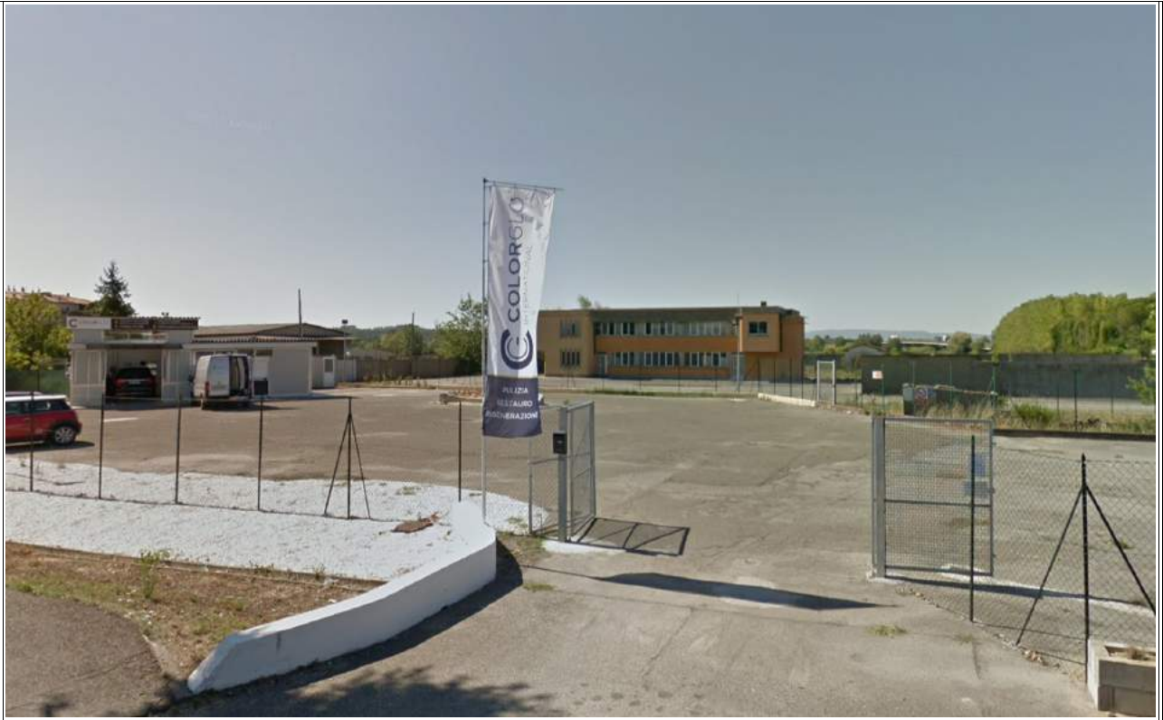
Fotografia n. 1 - Veduta lato Nord
