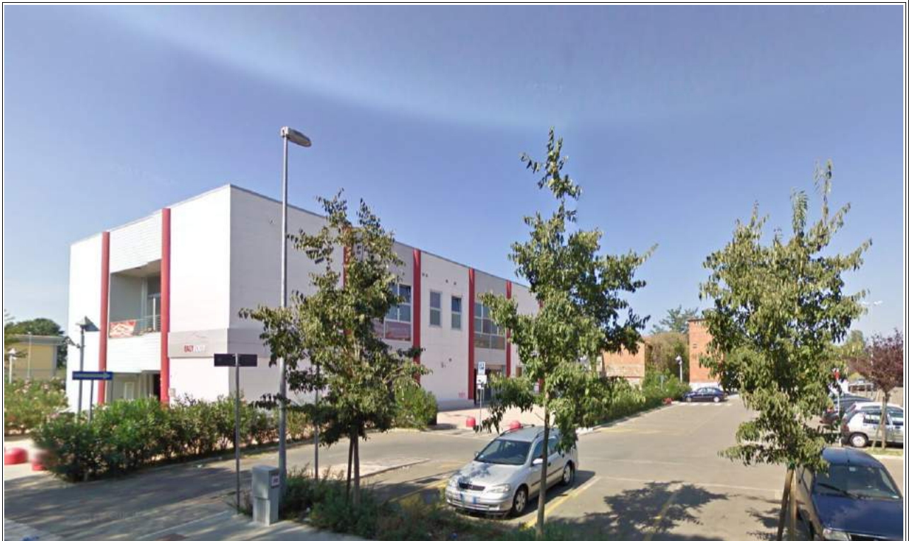
Fotografia n. 3 - Veduta lato Sud/Est
