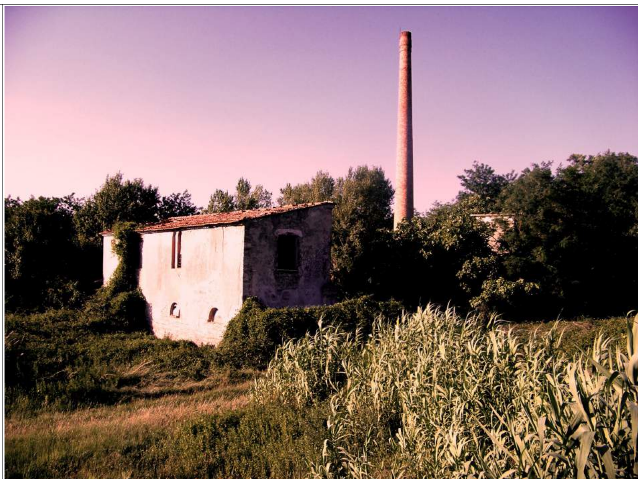
Fotografia n. 1 - Veduta lato Sud
