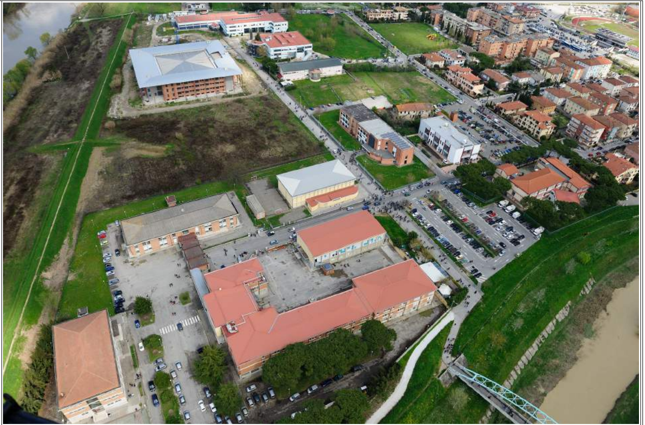
Fotografia n. 2 - Veduta lato Sud
